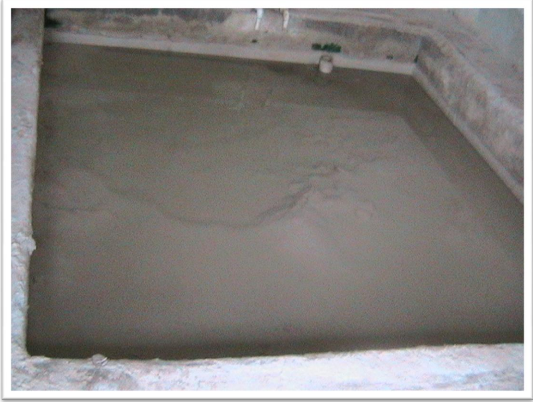
Fotoğraf – 9 Güney Kaplıca Tesisindeki bir şifalı çamur havuzu
