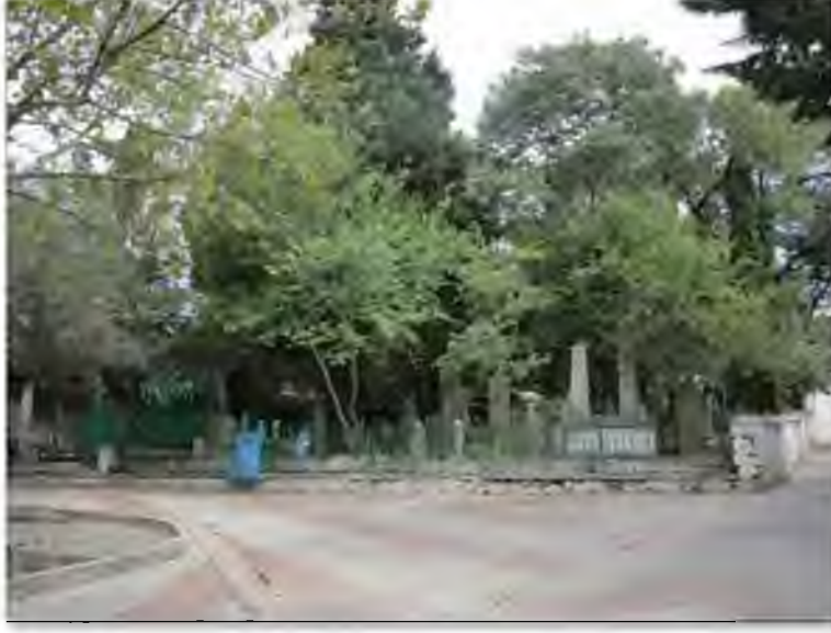
Şekil 10 Selami Ali Açık Türbesi ve Haziresi Restorasyon Öncesi Durumu
