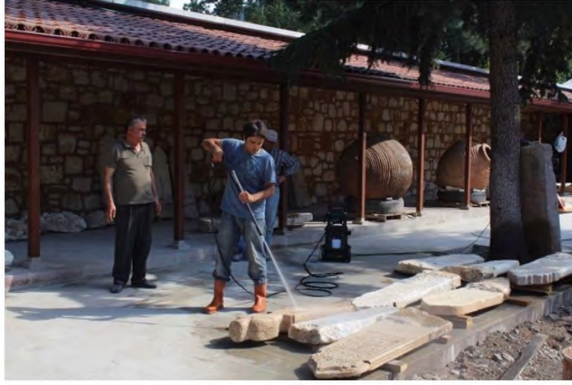
Fotoğraf 1: Akşehir Taş Eserler Müzesi'nde atomize su ile taş temizliği uygulaması.
