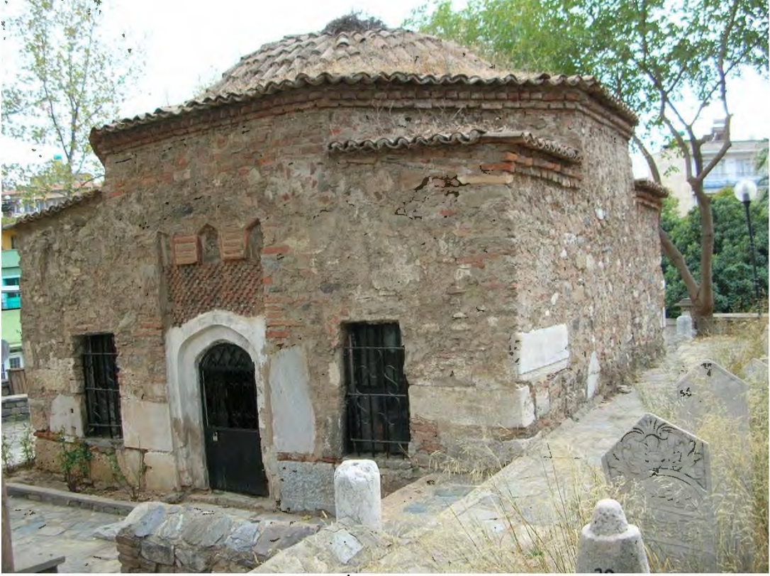
Fotođraf 21- Alihan Ođlu İsmail Türbesi, kuzeydođu cephesi.
