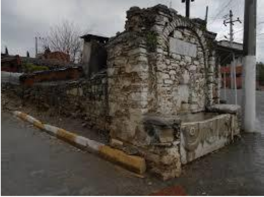
FOTO:1 Soğucak köy çeşmesi 95 ()
