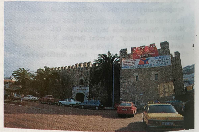
Res. 3. Kuşadası Öküz Mehmet Paşa Kervansarayı, kuzey cephesi.
