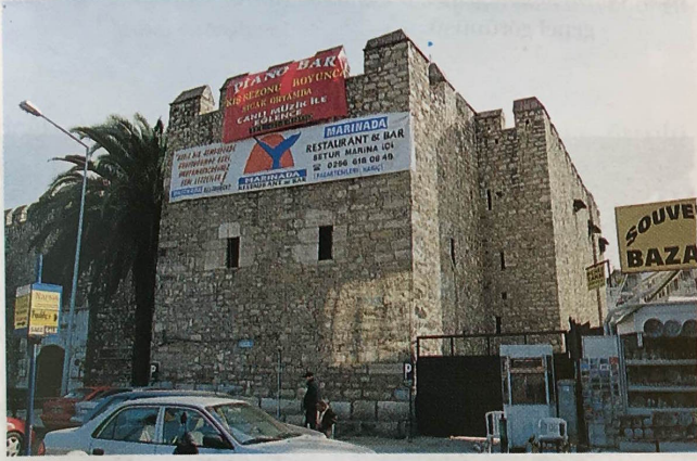
Res. 4. Kuşadası Öküz Mehmet Paşa Kervansarayı, kuzey cephenin batı ucu.
