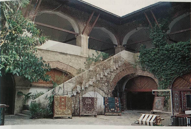
Res. 10. Kuşadası Öküz Mehmet Paşa Kervansarayı, doğu kanat merdiveni.
